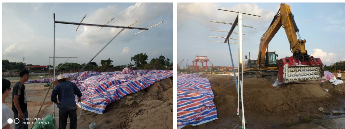
图 13：安装喷雾降尘装置、土壤修复过程喷雾降尘
